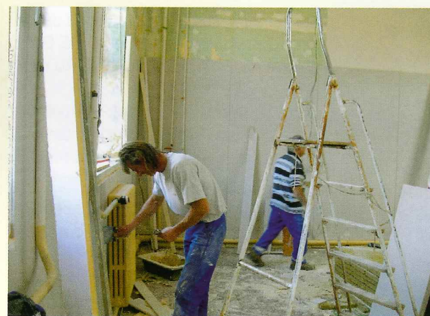
Travaux à l'école de la Sablière
