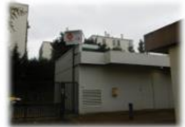
Une enseigne en infraction relevée.
