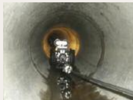
Robot d'observation dans une canalisation.
