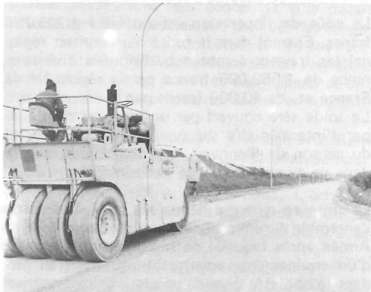
Piste cyclable et nouveau revêtement sur le CD 153.
