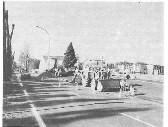
L'EDF en travaux sur la RN 191.
