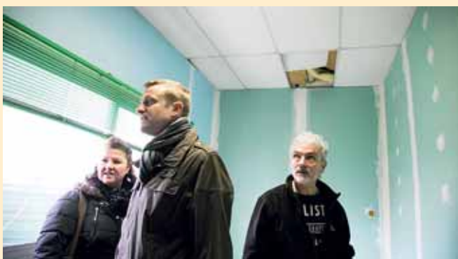
Visite de chantier
