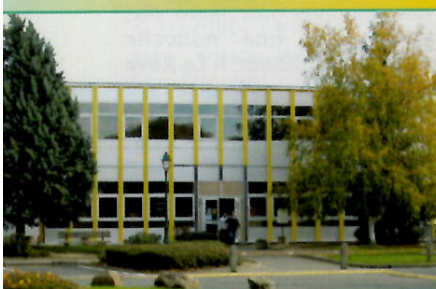
Rénovations dans les écoles
