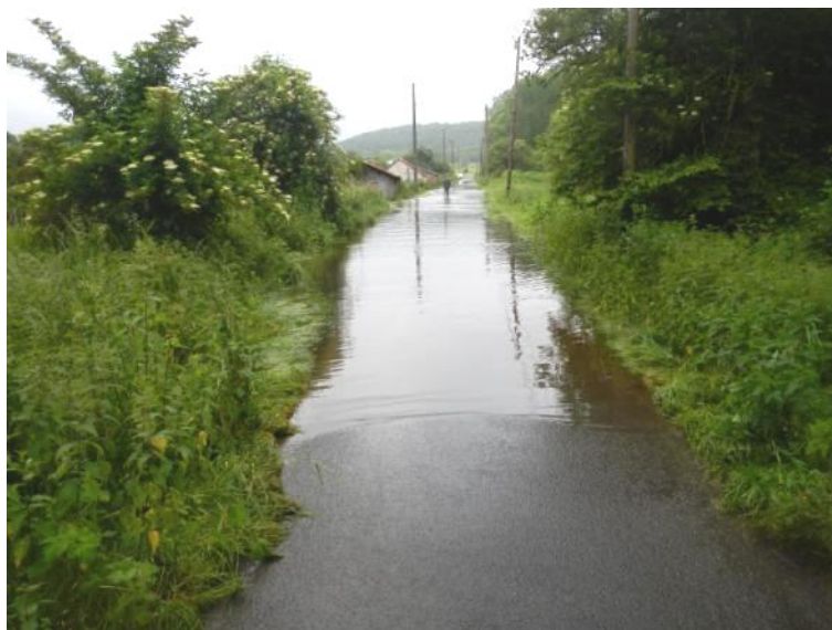
Figure 27 : la route du moulin Neuf, à Maisse, a aussi été traversée par une importante veine d'eau en rive droite, plus étalée et donc moins puissante que sa sœur rive gauche.
