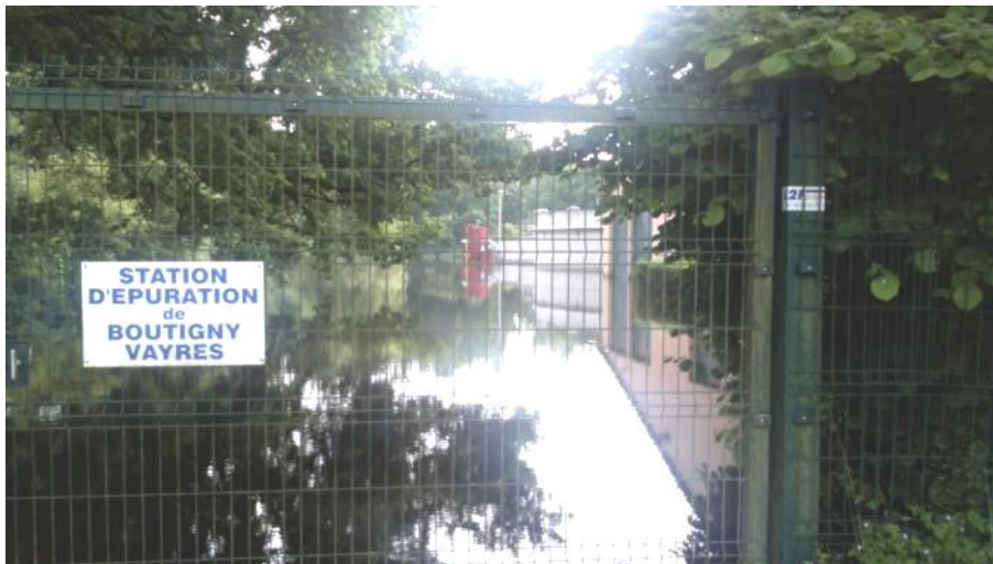
Figure 31 : Station d'épuration de Boutigny (arrêt complet)
