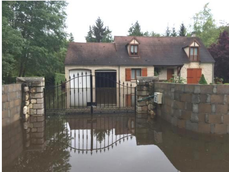
Figure 12 : une maison à Buno-Bonnevaux, située dans une zone sans exutoire direct vers le lit mineur. Une fois la crue passée, l'évacuation de l'eau sur ce type de secteur a été problématique
