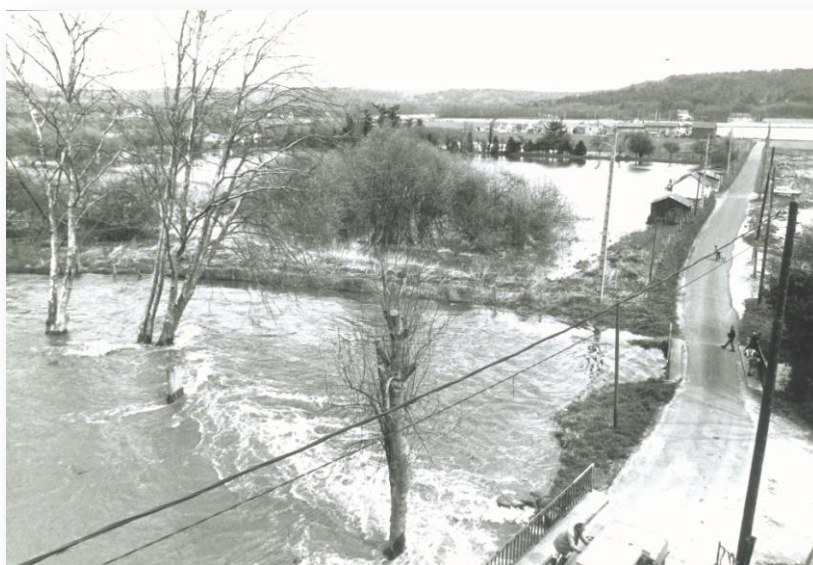
Vue de l'aval du Moulin Neuf à Maise pendant la crue de 1983
