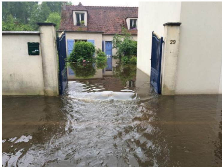
Figure 16 : une habitation à Buno-Bonnevaux, dans la rue du petit Gironville. Située entre deux bras de l'Essonne, une partie de l'onde de crue a traversé les jardins, les maisons et surversé la route pour poursuivre son chemin au travers des marais. De nombreuses maisons ont ainsi été durement touchées sur les communes de Buno-Bonnevaux, Gironville-sur-Essonne et Maisse.
