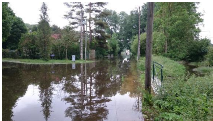
Figure 14 : Poste de Moignanville à Buno Bonnevaux sous l'eau et coupé d'électricité (armoire non touchée)
