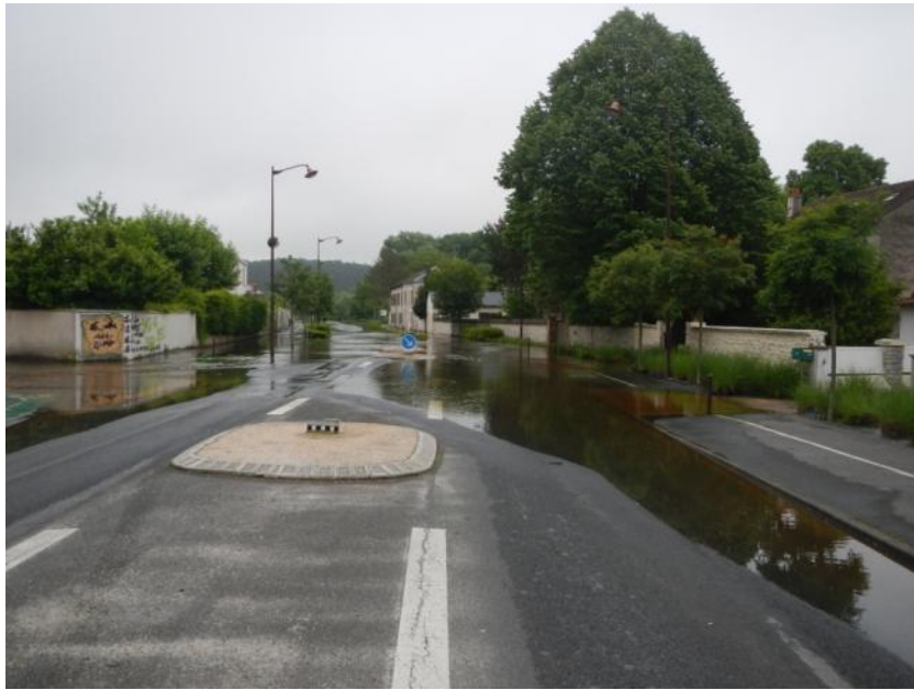
Figure 21 : L'avenue du Général de Gaulle à Maisse et la surverse en rive droite du bras droit
