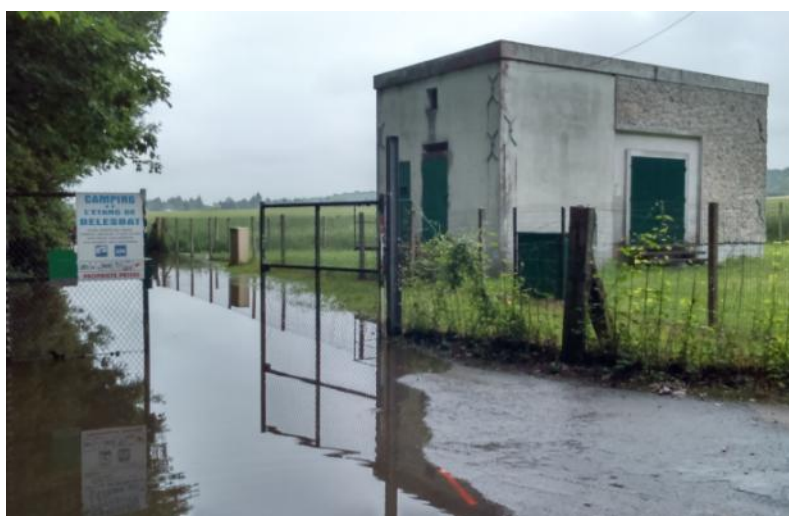
Figure 30 : Forage de Courdimanche – montée des eaux jusqu'au pied du forage
