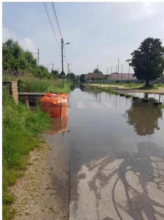
Figure 39 : Rue Fernand Laguide à Corbeil-Essonnes (remontée de l'Essonne via le réseau d'eaux pluviales)
