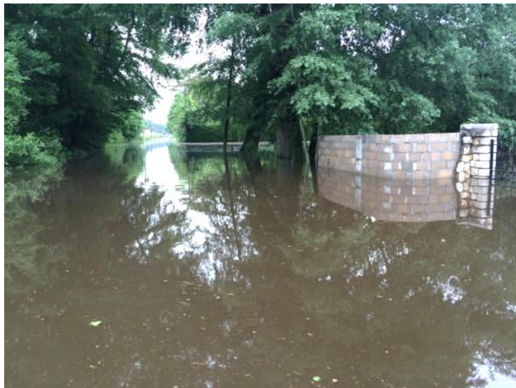
Figure 13 : la rue Jean-Claude Brégé à Buno-Bonnevaux a été fortement inondée. L'évacuation de l'eau sur ce secteur a posé des difficultés, compte-tenu de l'absence d'exutoire direct vers le lit mineur.
