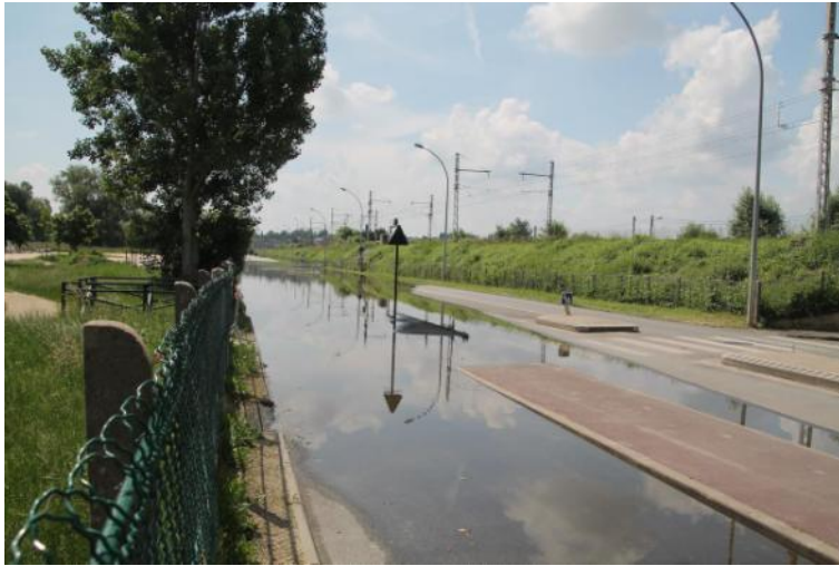
Figure 38 : Boulevard LeCouillard à Corbeil-Essonnes (remontée de l'Essonne via le réseau d'eaux pluviales)
