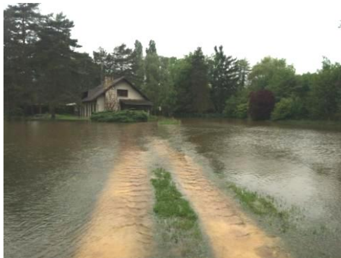
Figure 4 : maison inondée à Boulancourt, à proximité du camping
