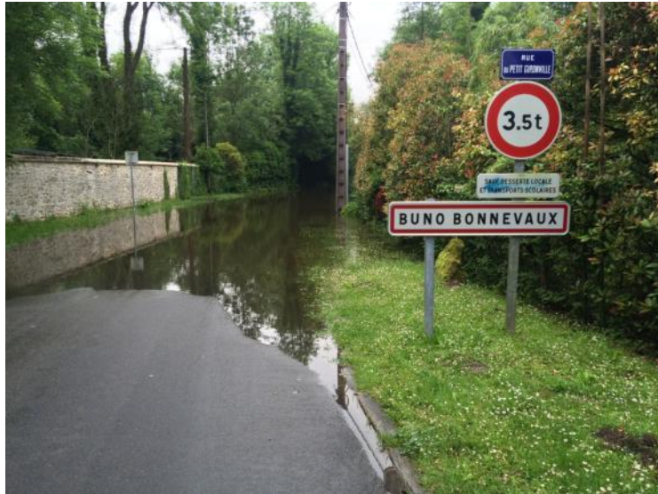
Figure 15 : la rue de l'Essonne au Petit Gironville et qui barre en travers la vallée, a été surversée sur près de 300 mètres.
