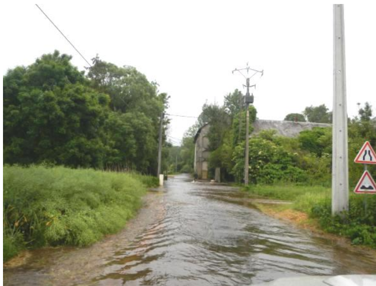
Figure 26 : la route du moulin Neuf, à Maisse, a été traversée par une importante veine d'eau en rive gauche qui a fortement endommagé le revêtement
