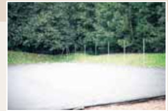
► Réfection de 4 courts de tennis en béton poreux (coût 92 900 €).
