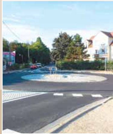
► Achèvement de la déviation du passage à niveau de la gare avec la réalisation du giratoire rue Abreuvoir-rue du Petit Mennecy-rue de Paris (coût : 340 000€).
