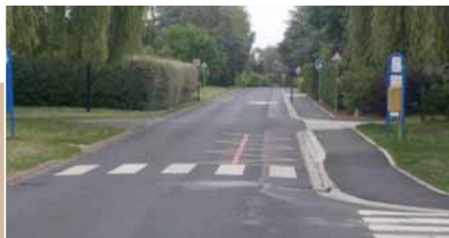
► Création d'un trottoir aux normes PMR (Personnes à mobilité réduite) avec réduction de la largeur de la chaussée avenue de Neuville pour limiter la vitesse de circulation des véhicules (Coût : 173 000€ TTC).
