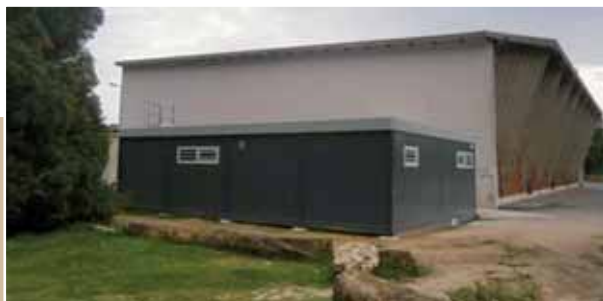
► Création de vestiaires à l'arrière du gymnase René Guiton (Coût : 177 000€ TTC).
