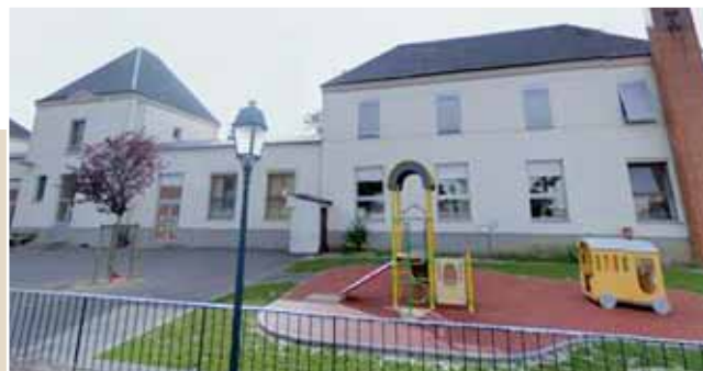
► Remplacement des menuiseries extérieures en bois par des menuiseries en aluminium à l'école de la Sablière (Coût : 92 000€ TTC).
