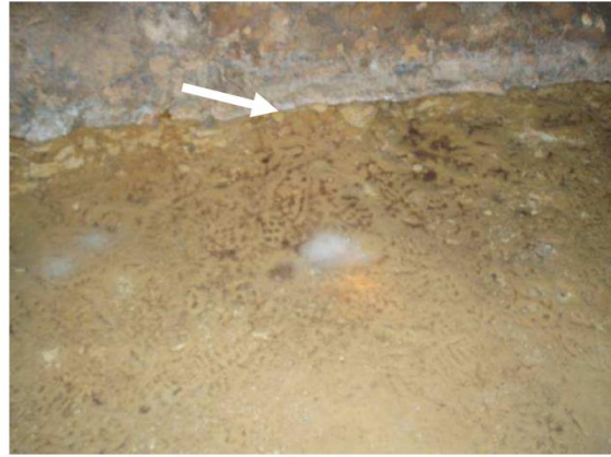
Bassin de captage sous le carrefour de l'Europe : l'aquifère «Calcaire de Brie» est visible (flèche).
