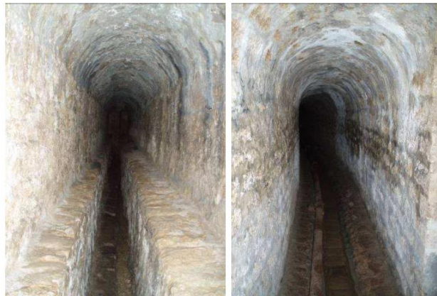
Galeries de l'aqueduc construites en moellons de grès et de meulière
