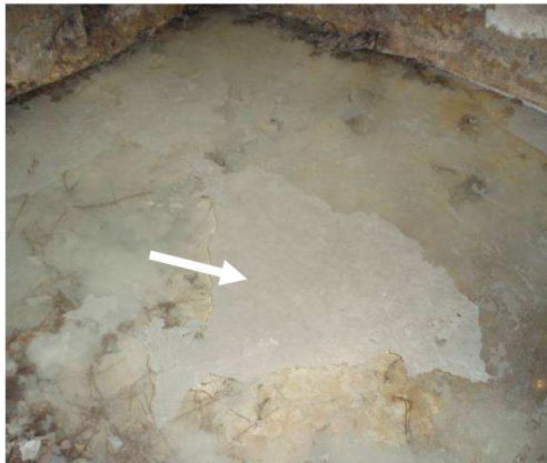
Second bassin de captage avec formation de « Calcite flottante »
